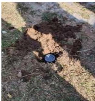
Gambar 5. Hasil Biopori yang Telah Dipasang
